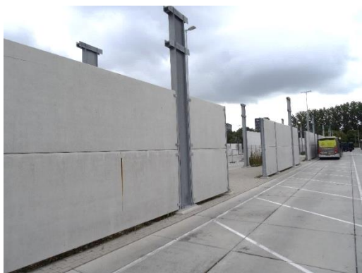
Brandscheiding met betonplaten
