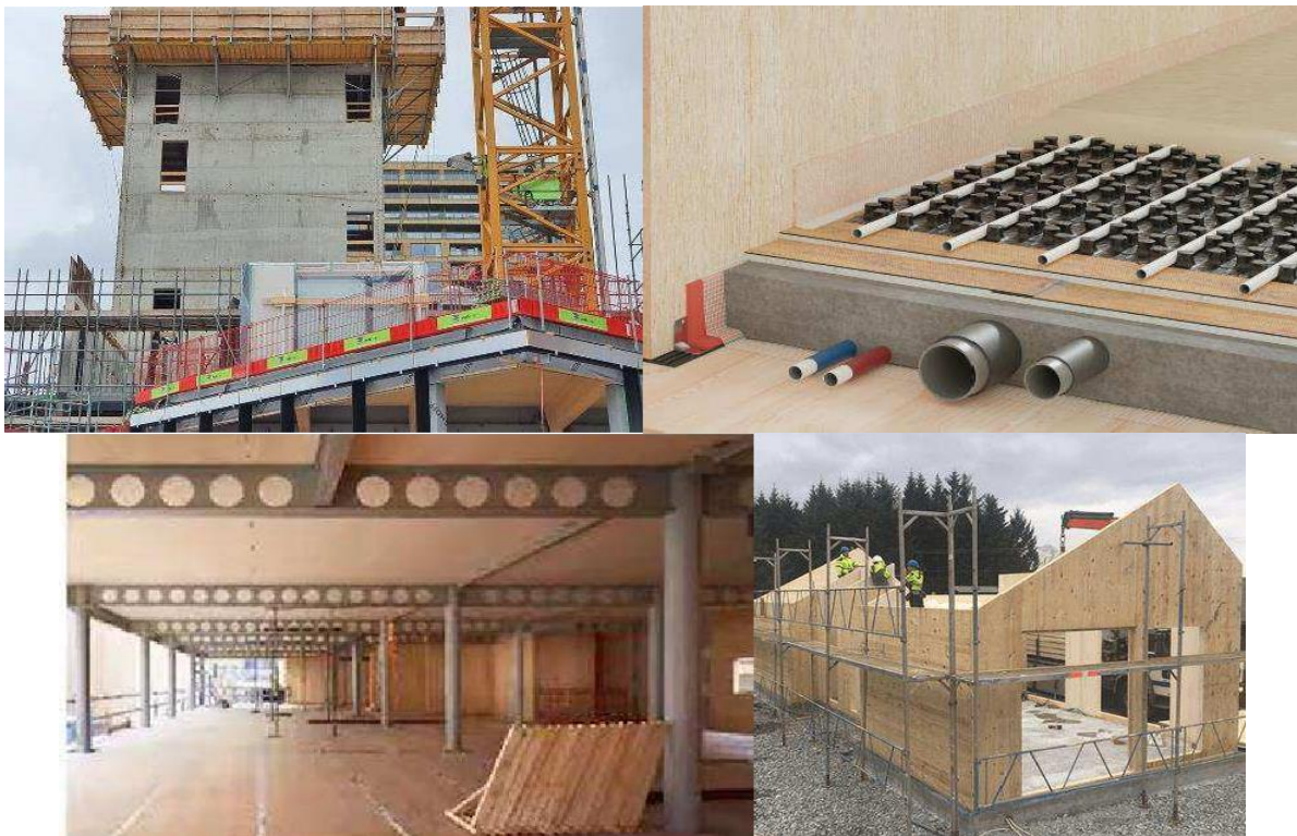
Figuur 1 hybride gebouwen: betonnen kern, combinatie vloer beton & CLT (zie par. 14), stalen draagconstructie met CLT vloer, betonnen fundering. Bron: Haut, redumax, waughthistleton, wonen in hout
