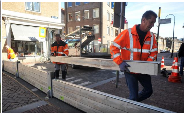
Figuur 5-7: Overstromingsmuren worden tijdelijk geplaatst in Dordrecht. (bron: BN De Stem, 2023)
