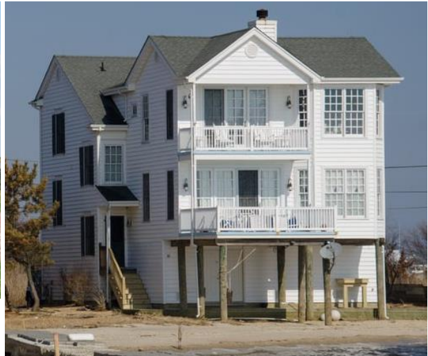
Figuur 5-5: Voorbeeld van een huis op palen in Bayville New Jersey (bron: FEMA)
