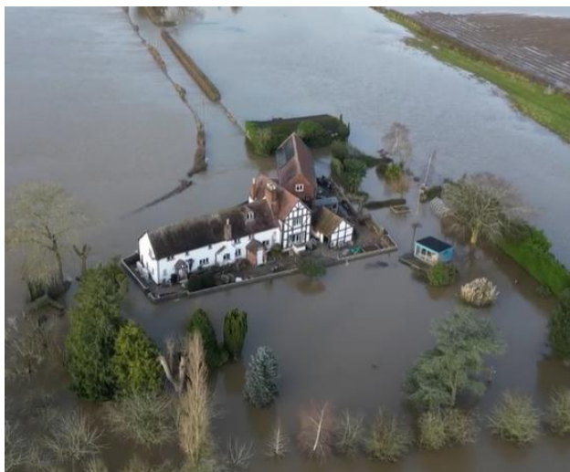
Figuur 5-6: Overstromingsmuren beschermen een 17e-eeuwse woning in Pixham, Engeland. (bron: AD)
