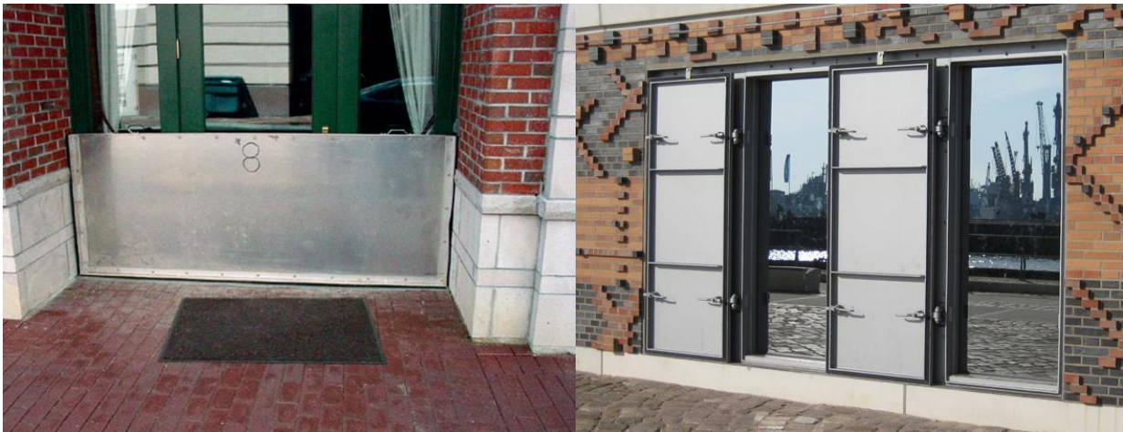
Figuur 5-1: Voorbeeld van een overstromingsschild van 1 meter hoog (bron: FEMA)
